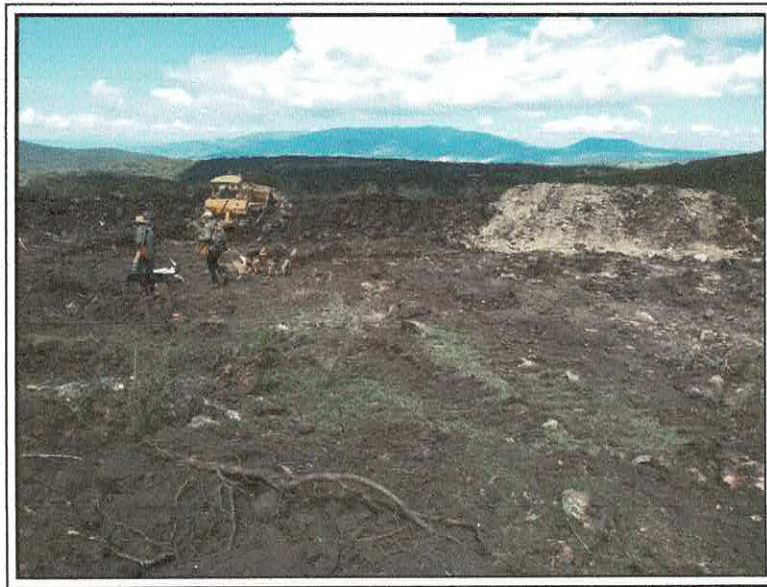
Ejecución de obras
