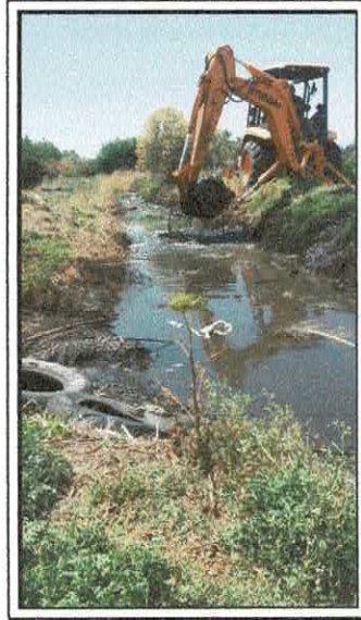
Ejecución de Obra
